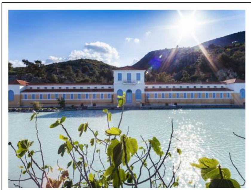
Εικόνα 94 Το μνημειώδες κτίριο των θειούχων πηγών των Μεθάνων
